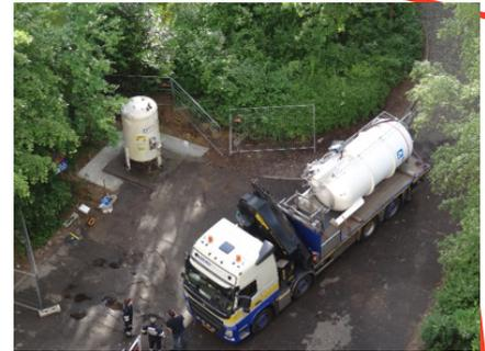
Remplacement du réservoir d'azote par une capacité de 5250L
