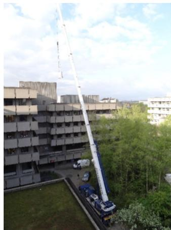
Montée d'un groupe de climatisation sur le toit du bâtiment
